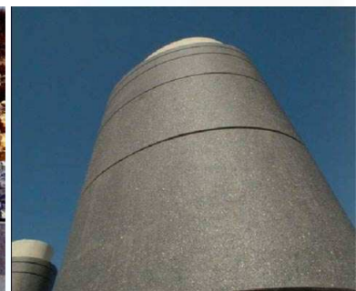
Coque de pile
