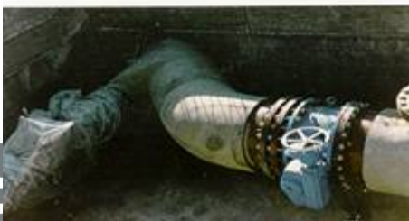
LAUSANNE - Chambre de vannes
